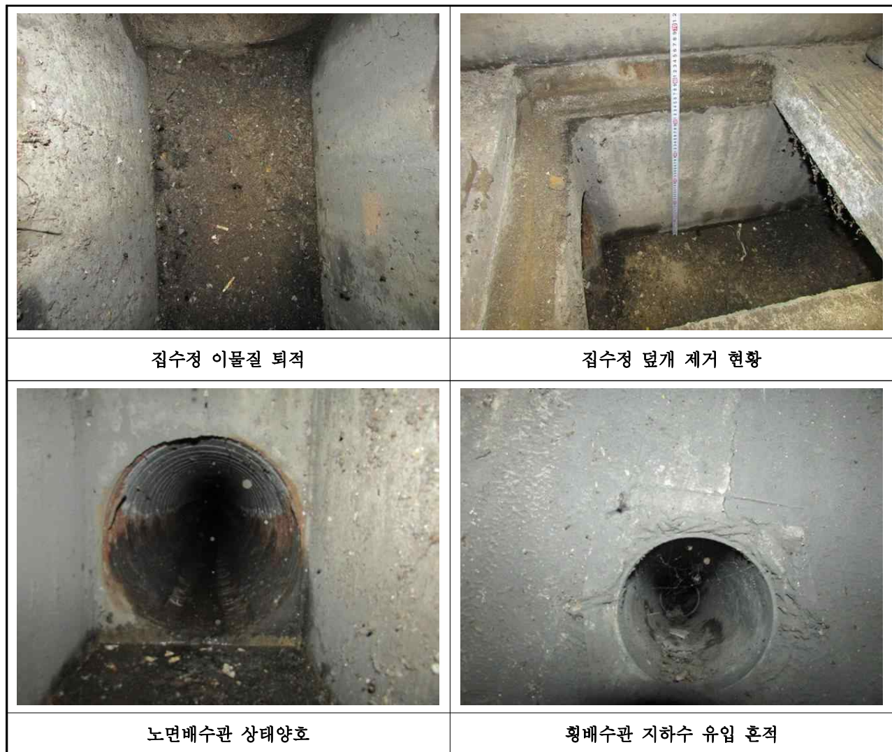
【사진 1.1.7】 배수시설 외관조사 결과
