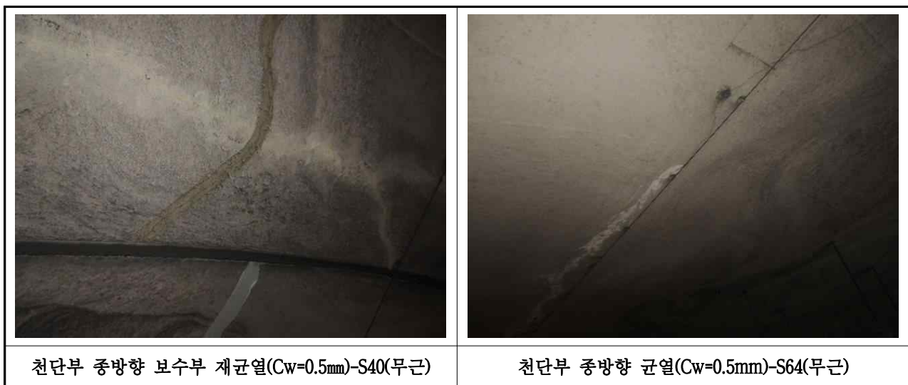
【사진 1.1.1】 라이닝 외관조사 결과(1)
