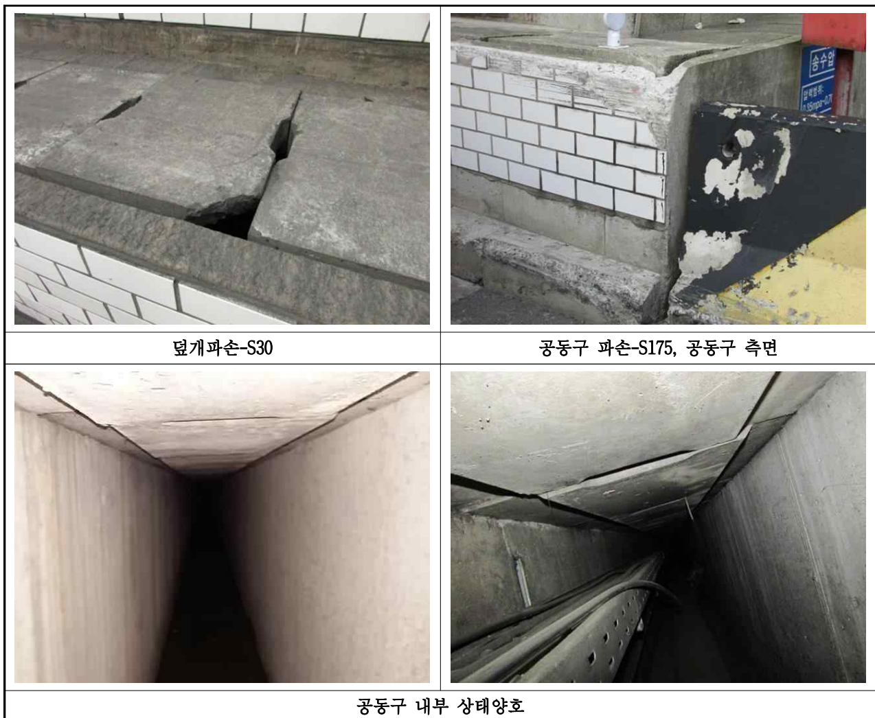
【사진 1.1.6】 공동구 외관조사 결과
